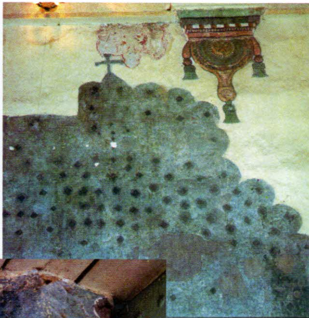
19.- Pintura mural de la nave de la iglesia y ménsula.
