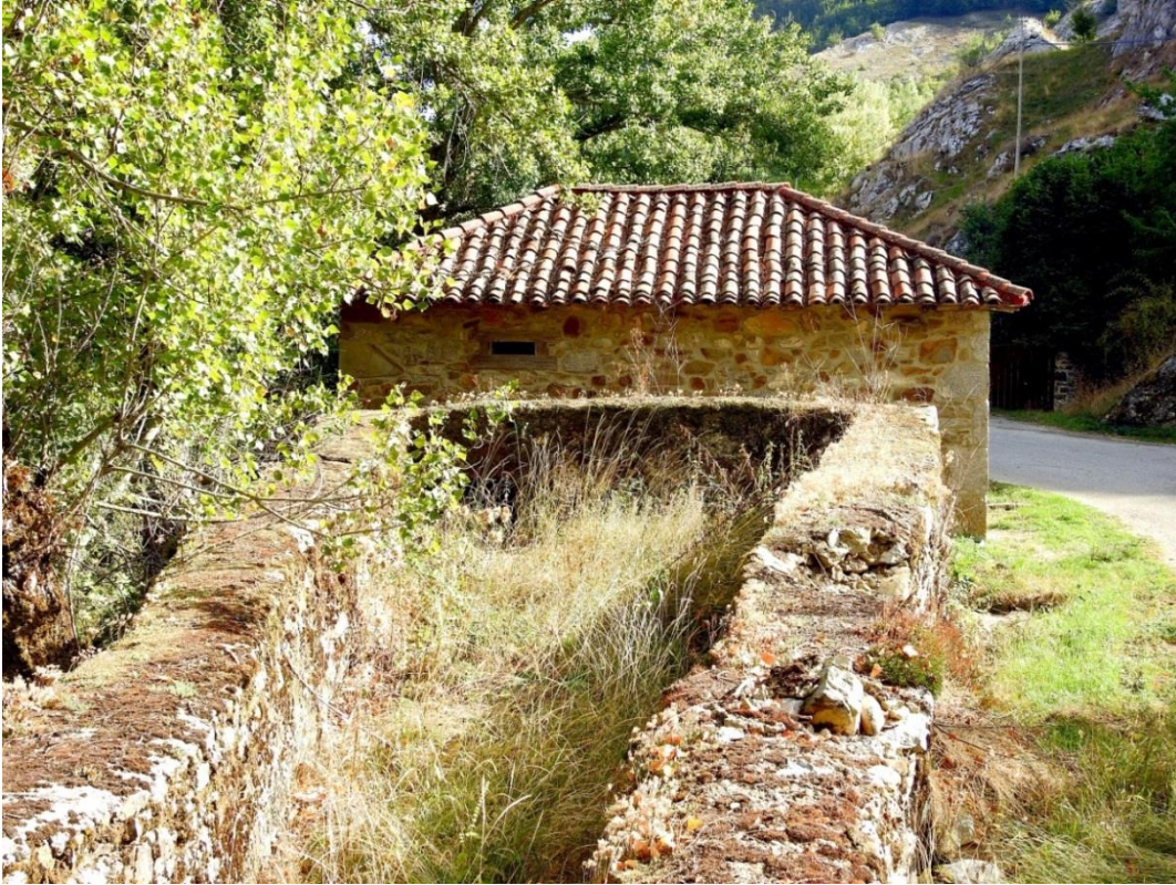
Ilustración 3: Cámara de carga (Fuente: Antonio Carrio)
