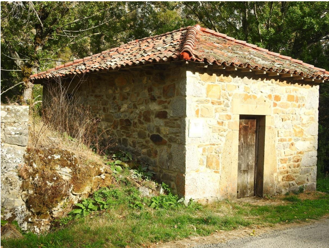
Ilustración 4: Frente de la casa de máquinas (Fuente: Antonio Carrio)
