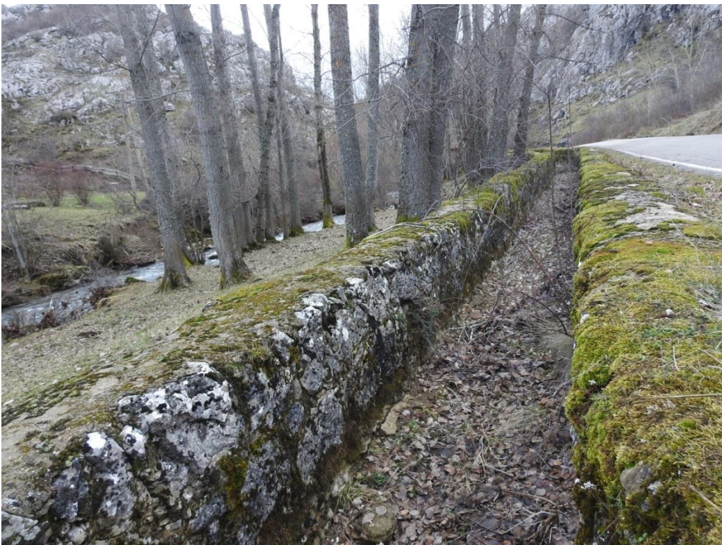
Ilustración 2: Canal de derivación (Fuente: Antonio Carrio)
