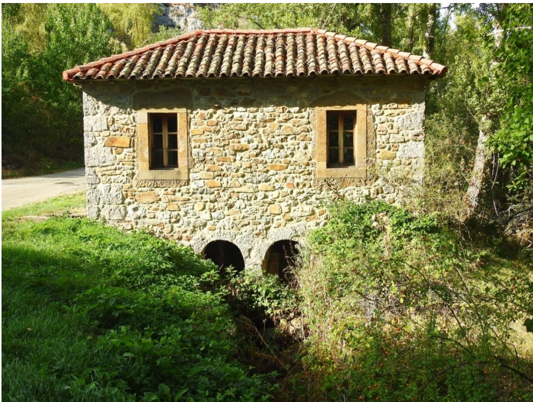
Ilustración 6: Socaces y canal de restitución (Fuente: Antonio Carrio)
