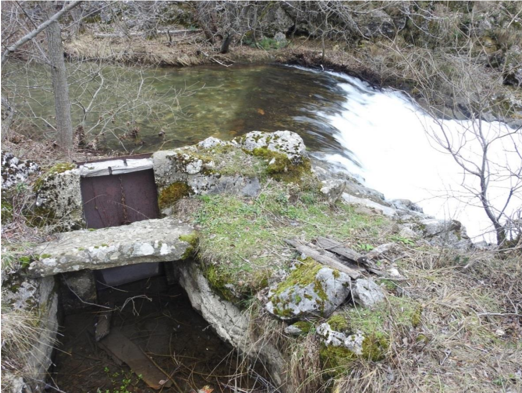
Ilustración 1: Azud y vertedero de entrada al canal de derivación (Fuente: Antonio Carrio)
