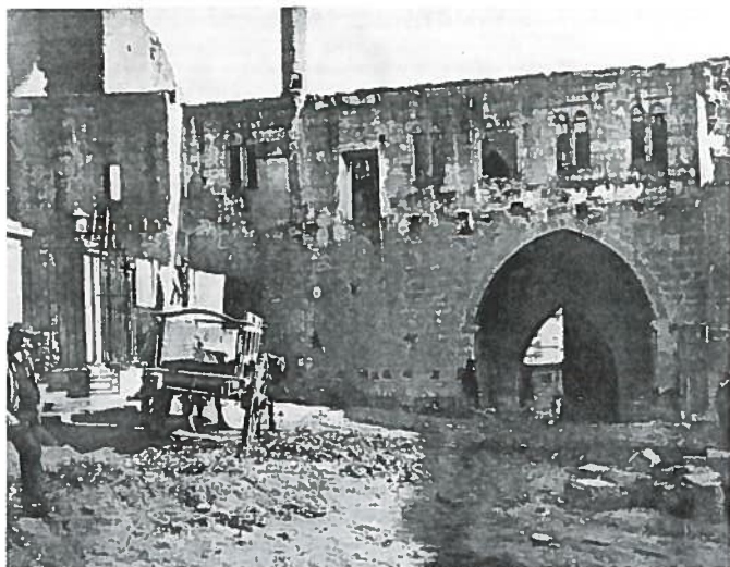
Fig. 3: Antigua Puerta del Obispo demolida. Gómez Moreno, Catálogo Monumental de la provincia de León, lámina 413.
