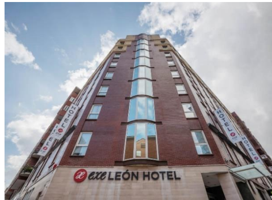
Imagen 5.3.- Fachada del Hotel Exe León
