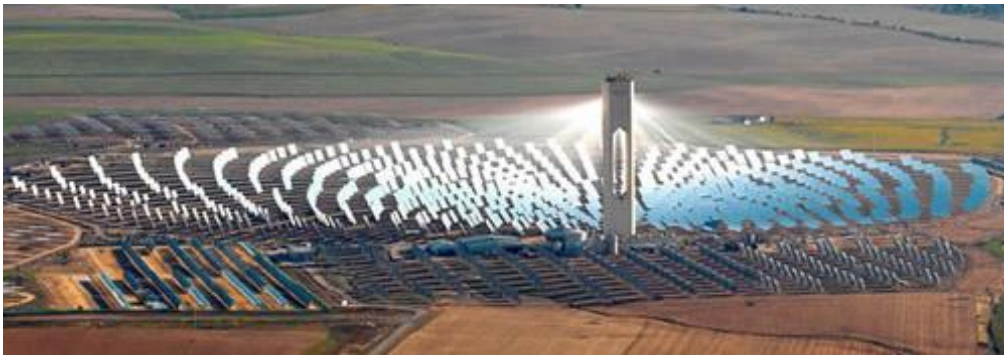
Figura 10 - Primera central solar termoeléctrica de campo de heliostatos instalada en el mundo [8]
