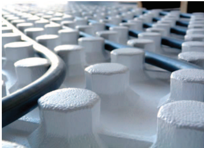
Figura 1-29 Tubo encajado en aislamiento base con tetón
