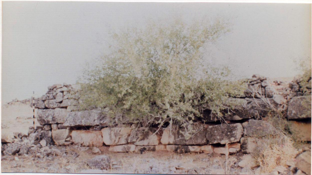
Fig. 7b.- Estructura n° 9.
