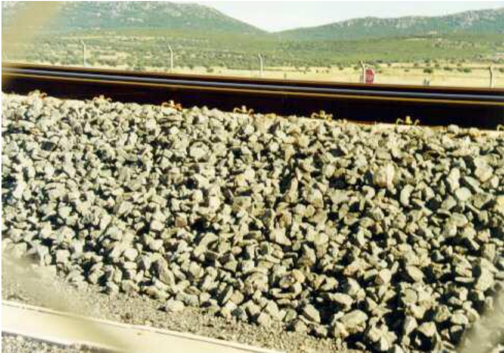
Figura 1.3.1.2. Vía Sobre Balasto
