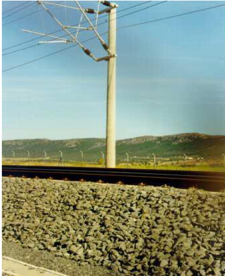
Figura 1.3.1.1. Vía Sobre Balasto
