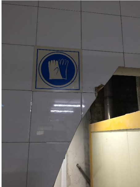
Imagen 35. Esta señal se sitúa a la derecha del horno de pisos e indica la obligación del uso de guantes térmicos para trabajar con el horno y guantes de seguridad para el manejo de la leña. Elaboración propia.
