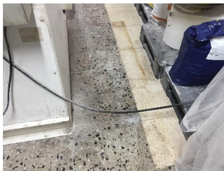
Imagen 22. Cable en medio de una zona de paso. Elaboración propia.
