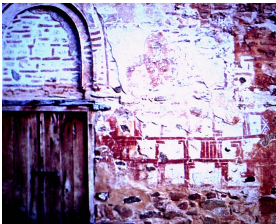
■ Lám. 5. Kurbinovo (Macedonia). Iglesia de San Jorge. Fachada principal. Detalle del revoco decorativo.
