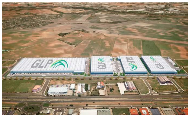
Figura 3.4. Parque logístico “Magna Park Tauro” en construcción por parte de la empresa GLP en Illescas (Toledo).
