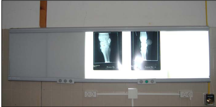
Figura 70.- Negatoscopio de 1800mm x 500mm x 120mm.
