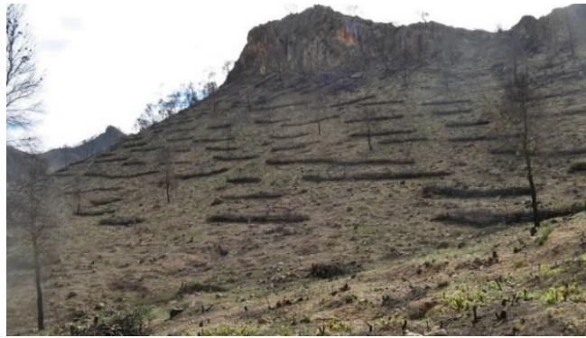
Figura 3. Uso de fajinadas para la protección del suelo tras un incendio. Fuente: Lucas-Borja et al. (2021)
