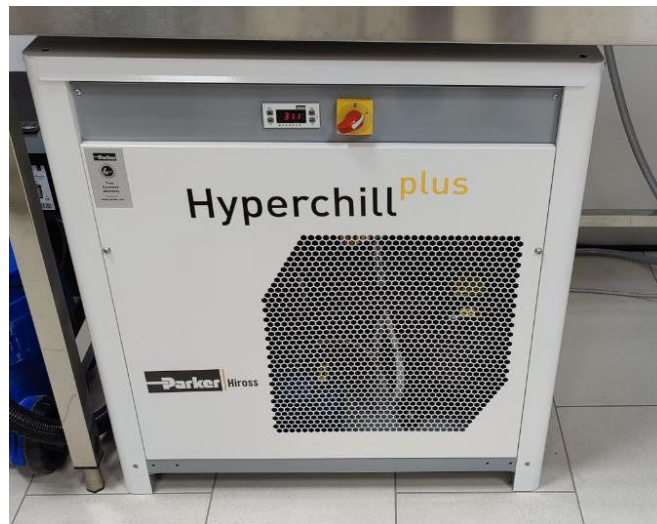
Figura 4.14. Fotografía del chiller empleado para el proceso de debinding disponible en la unidad UFI3D de la Universidad de León.
