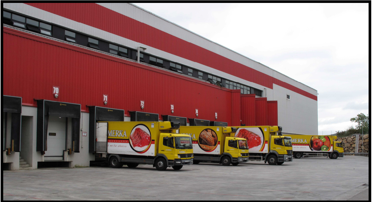
Figura 8.2: Camiones en los muelles de la plataforma.
