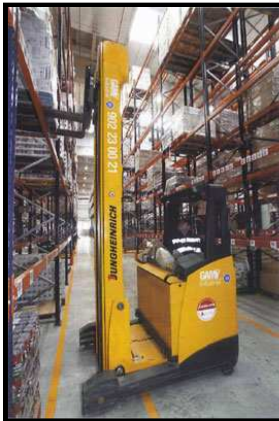
Figura 8.10: Instalaciones para almacenaje producto seco
