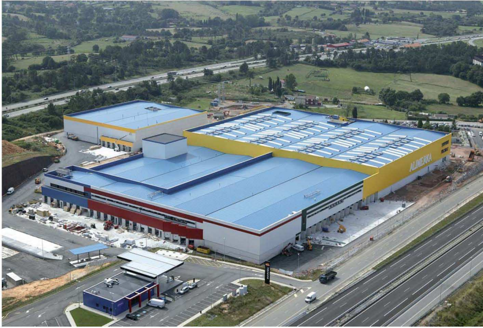
Aspecto de las obras en agosto de 2009
