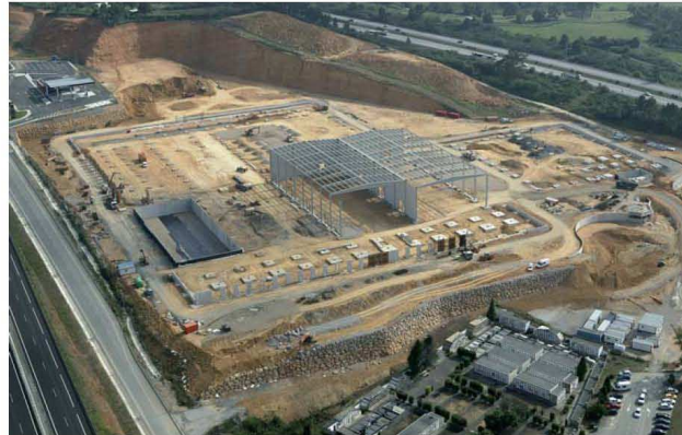
Aspecto de las obras en agosto de 2009
