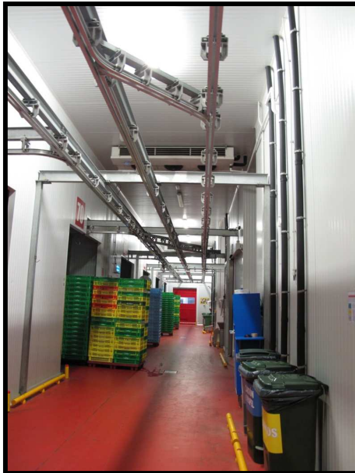
Figura 8.4: Pasillo con carriles para transporte piezas de carne
