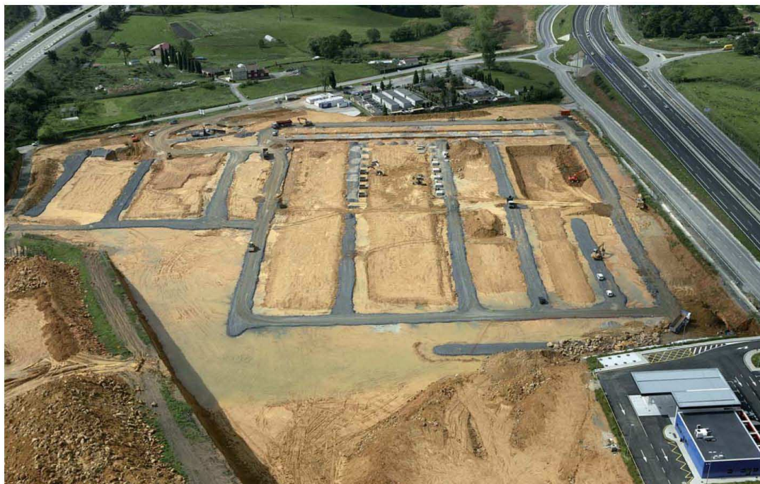
Aspecto de las obras en su inicio en mayo de 2008
