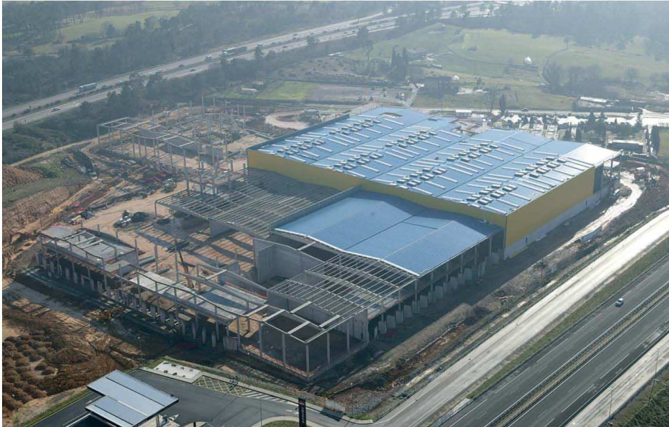
Aspecto de las obras en enero de 2009
