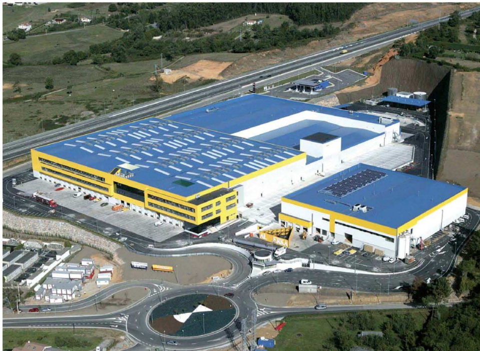
Aspecto de las obras en septiembre de 2009
