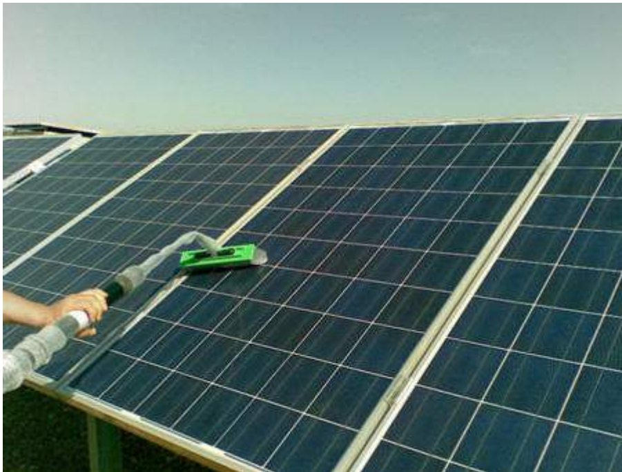
Figura 6.1-3.Limpieza paneles fotovoltaicos
