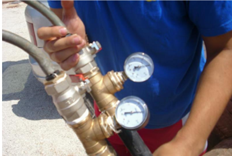
Figura 4.14 prueba de estanqueidad de la sonda
