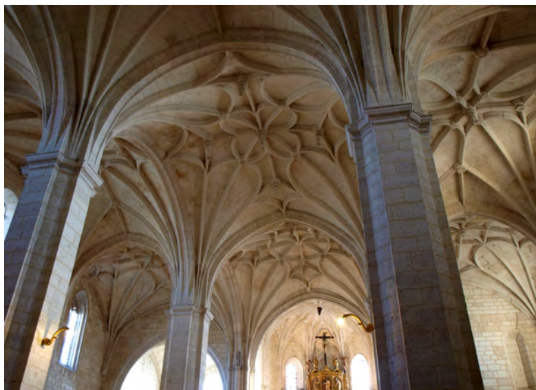
Fig. 3. Cubiertas de la iglesia de San Nicolás. Santibáñez-Zaraguda (Burgos).
