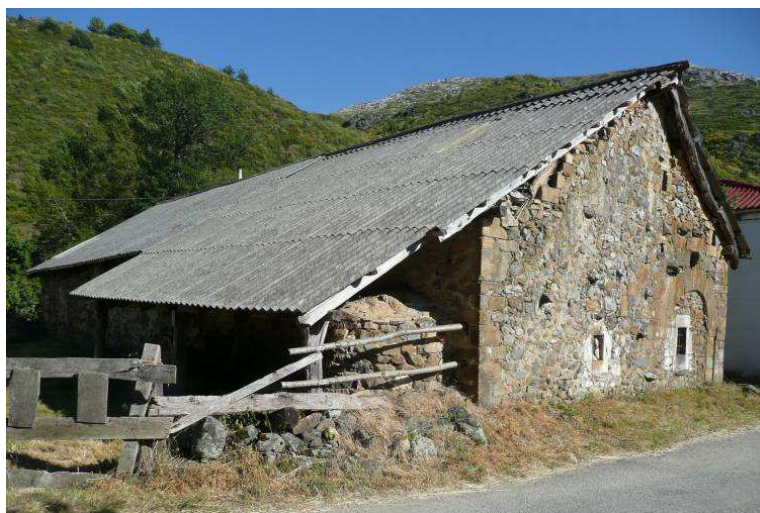
Fotografía 57.- Casa de Gerardo González en Los Espejos de la Reina. La cubierta de paja fue sustituida hace unas décadas por fibrocemento. [Miguel Cimadevilla]
