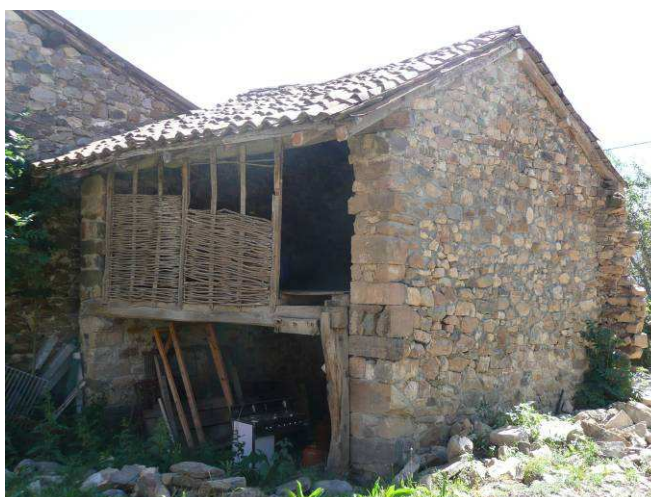
Fotografía 44.- Boca de Huérgano. Cerramiento a base de entramados de madera. [Miguel Cimadevilla]
