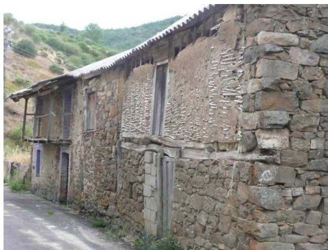
Fotografía 45.- Siero de la Reina. Entramado de madera. [Miguel Cimadevilla]
