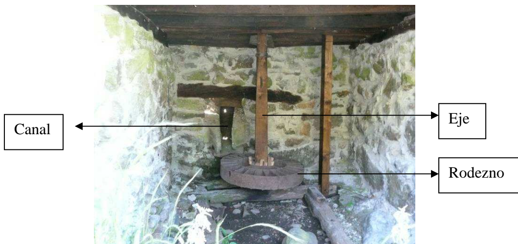
Fotografía 105.- Barniedo. Eje y rodezno de un molino. [Miguel Cimadevilla]
