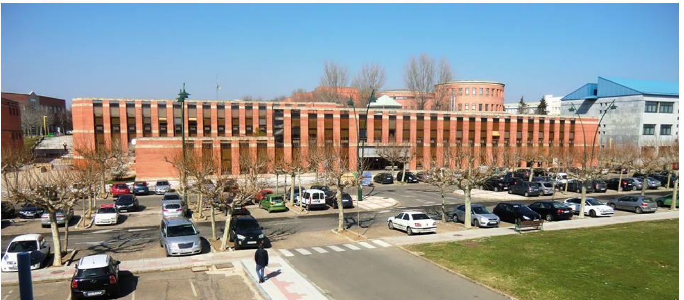
Figura 6-3 Escuela Superior y Técnica de Ingenieros de Minas. Fuente [21]
