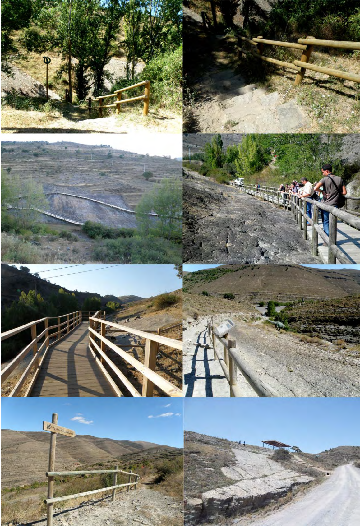
Figura V.2. Infraestructuras de acceso de tipo mobiliario presentes en los yacimientos de icnitas de dinosaurios de La Rioja. Son de tipos diferentes: escaleras, pasarelas, barandillas, caminos...; y la mayoría, aparte de cumplir una función de acceso, tienen un objetivo de uso turístico. Otras, como las pasarelas, también desempeñan funciones secundarias como la protección frente a amenazas antrópicas al canalizar el turismo.
