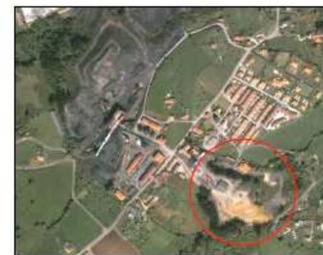
ZONA ACTUACIÓN. ESCOMBRERA SUR
