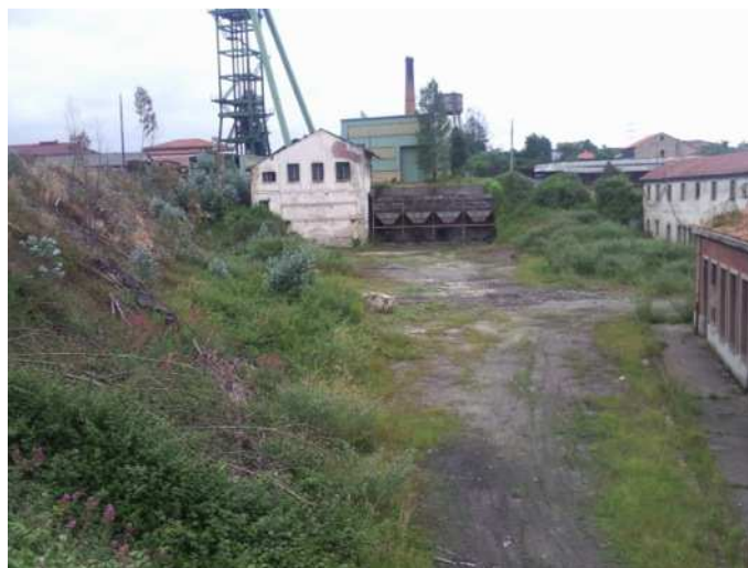
Imagen 57.- Vista parcial de hueco, instalaciones, economato y casa de máquinas
