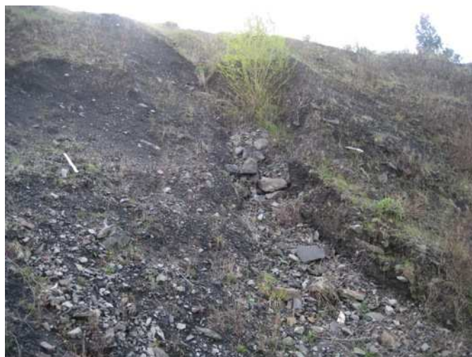
Imagen 53.- Efectos de la escorrentía superficial en la escombrera
