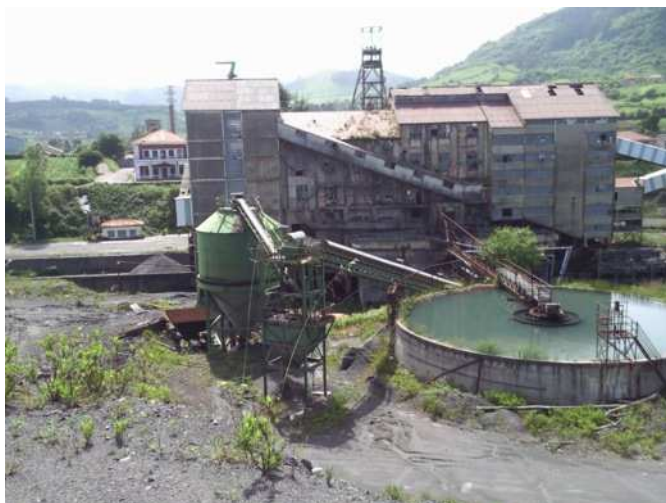
Imagen 58.- Vista del lavadero e instalaciones varias (Demolición)
