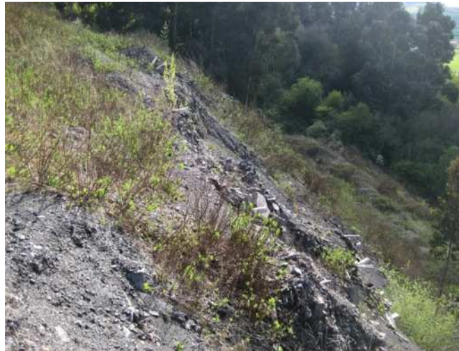
Imagen 51.- Aspecto general de la inestabilidad
