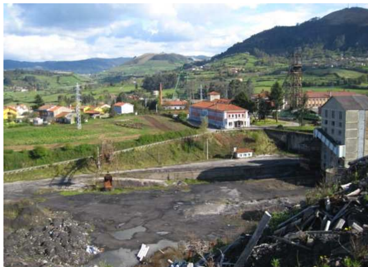
Imagen 42.- Límite sur de la escombrera. Lavadero y resto de instalaciones
