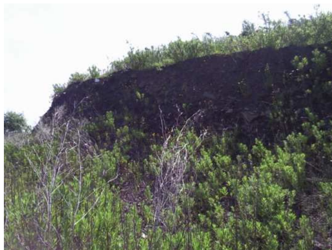
Imagen 46.- Escarpe provocado por una grieta deslizante
