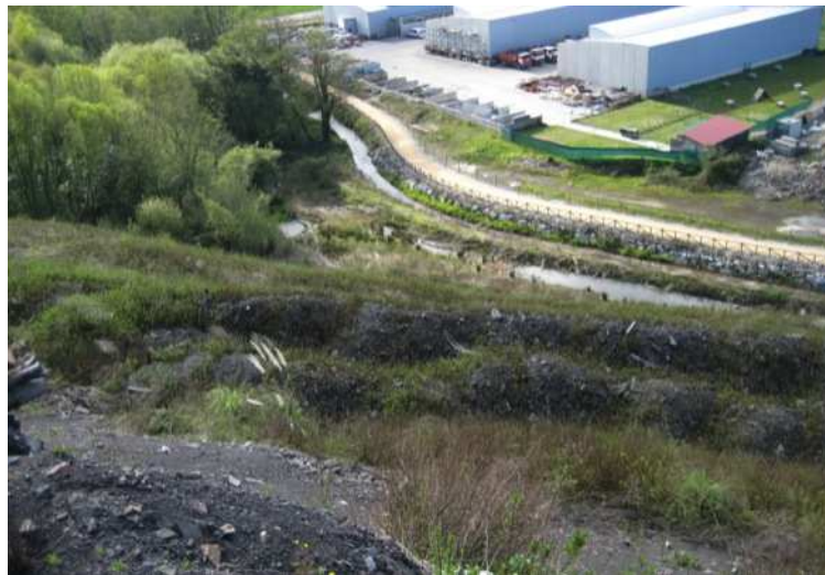
Imagen 41.- Límite norte de la escombrera. Arroyo Llantones y Senda Verde
