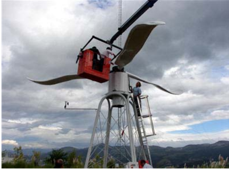
. Figura 31. Aerogenerador de eje vertical de 5 KW de última generación diseñado para instalaciones sobre edificios
