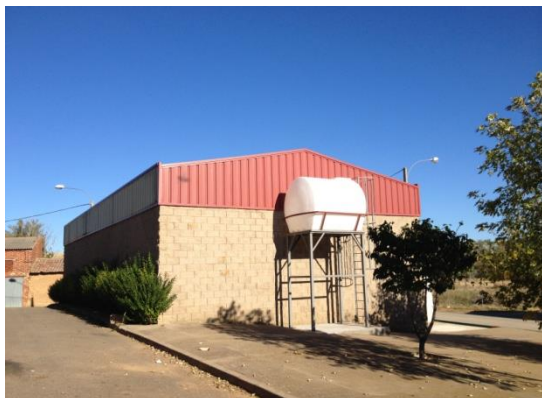
Lugar actual donde se encontraba la Iglesia del Salvador (Valdemora)
