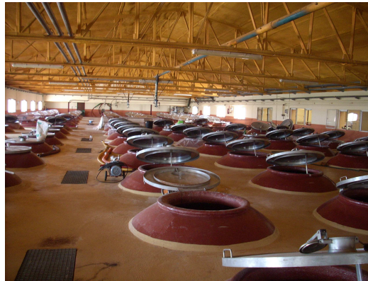
Figura N°19: Nave de tinajas Fuente: Propia
