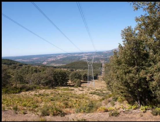
Foto 4. Pérdida y fragmentación de robledal maduro en Valderrueda debido a la construcción de la línea de alta tensión.
