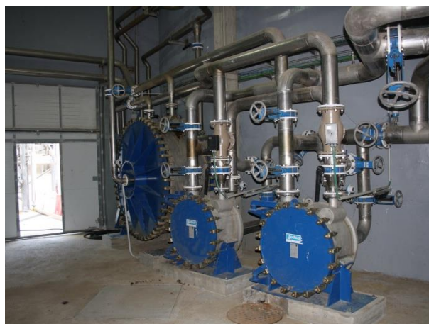
Figura 5.5. Intercambiador de fango hidrolizado de los escenarios 2, 3 y 4 (EDAR, 2016).
