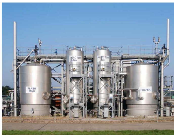
Figura 2.10. Unidad de hidrólisis térmica Cambi modelo THP-B6.2 (Cambi1, 2017).
