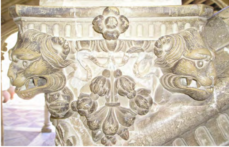
Fig. 8. Cabezas de leones en el segundo montante de la escalera del Hospital de Santa Cruz, Toledo.
