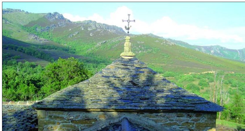
■ Fig 6. Iglesia de Pozos. Cubierta de losas de pizarra a dos, tres y cuatro aguas.
