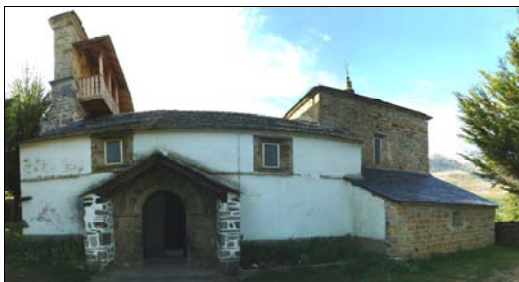
■ Fig 3. Panorámica cilíndrica correspondiente a la fachada con orientación meridional.
