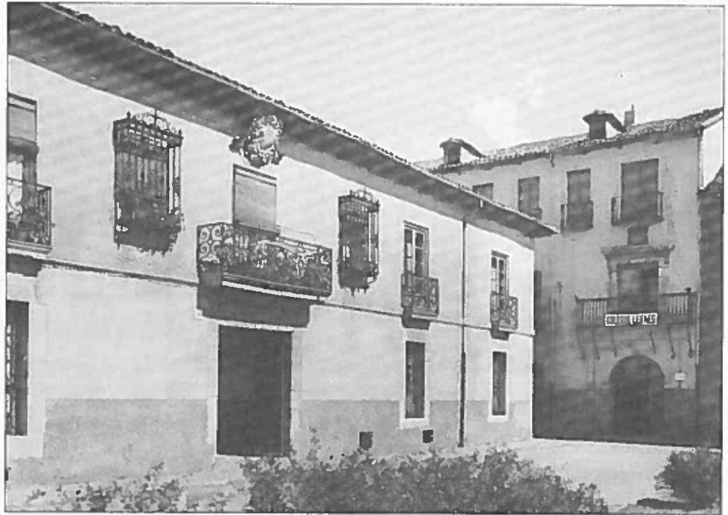
DF.5. Aspecto del edificio (h. 1957) antes del inicio de las obras, en que se respeta el "majestuoso balcón que marca la directriz estructural de todos sus componentes".
