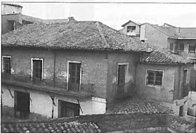
DF.3. La serie de fotos que poseemos, todas ellas datadas en 1961, nos muestran diversos aspectos del antiguo edificio del colegio, con sus alturas y el patio y las dos salidas, o entradas, detalle al que se hacen algunas referencias, incluso en algunos momentos una para niñas, otra para niños. Por razones de espacio, sólo podemos reproducir una.
