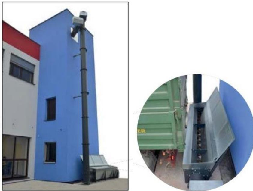
Figura 10.5. Almacén de combustible situado al lado de la sala de calderas de “Catalogo Grandes proyectos” (HERZ y Termosun Energías, 2019, p. 22)
