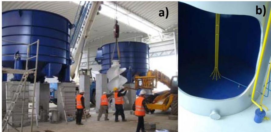
Figura 1.4 Sistema BTA. a) Agitación mecánica; b) Agitación mediante recirculación de biogás. ( http://www.bta-international.de/en/home.html 2019)
