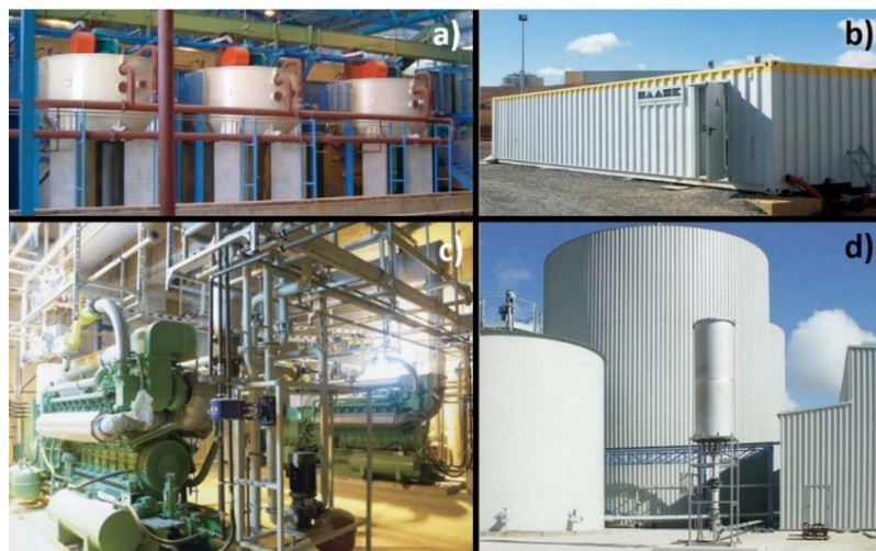
Figura 1.5 Unidades de la planta de digestión anaerobia de San Román de la Vega (León). a) mezclador; b) ósmosis inversa; c) unidad estacionaria de cogeneración CHP; d) antorcha de biogás tipo LTU (Martens 2005)
