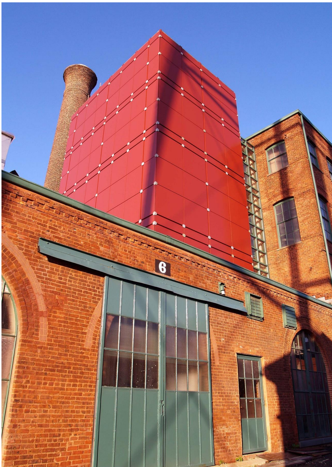
Nueva torre de escaleras y ascensor unidos al exterior del edificio 5. Cortesía del NationalPark Service, U.S. Dept. of the Interior. Recuperado de https://www.nps.gov/npgallery/GetAsset/B6EAA4E9-155D-451F-67FADB80CCDE2F40/proxy/hires/
