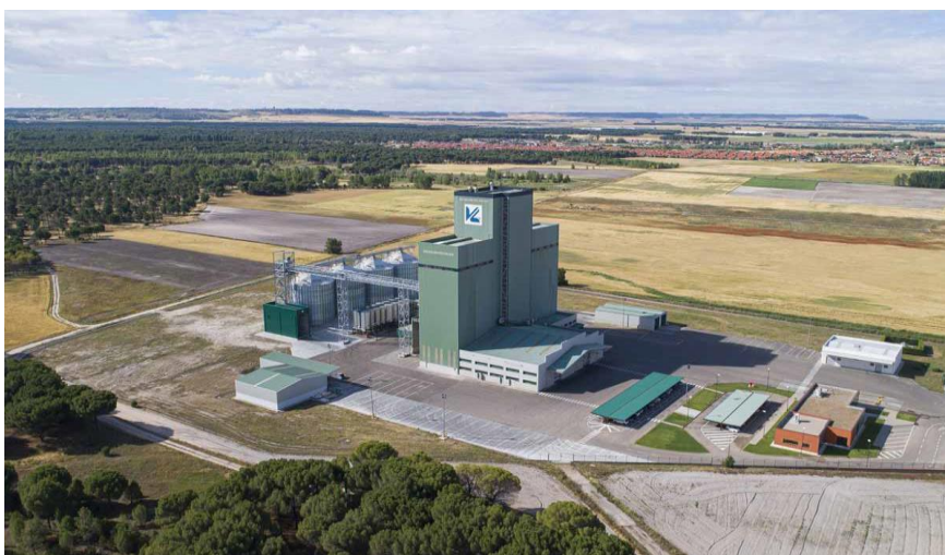
Imagen 4.2: Fábrica de piensos de la integradora Valls Companys en Aldeamayor de San Marín (Valladolid)
