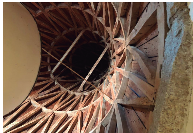
Figura 1. Palacio episcopal de Astorga: interior del chapitel del torreón norte. (Fotografía del autor del artículo).
