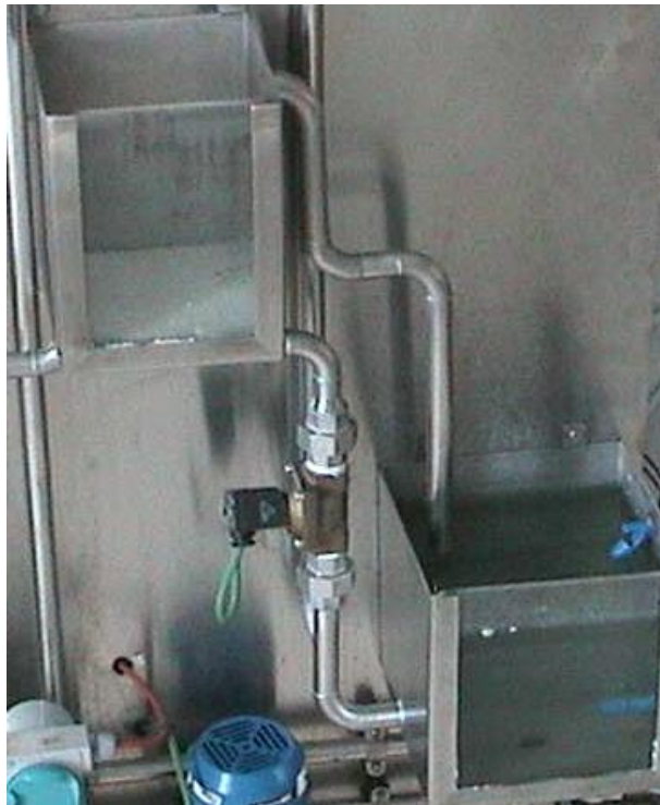
Ilustración 4.3 Electroválvula entre tanques de proceso
