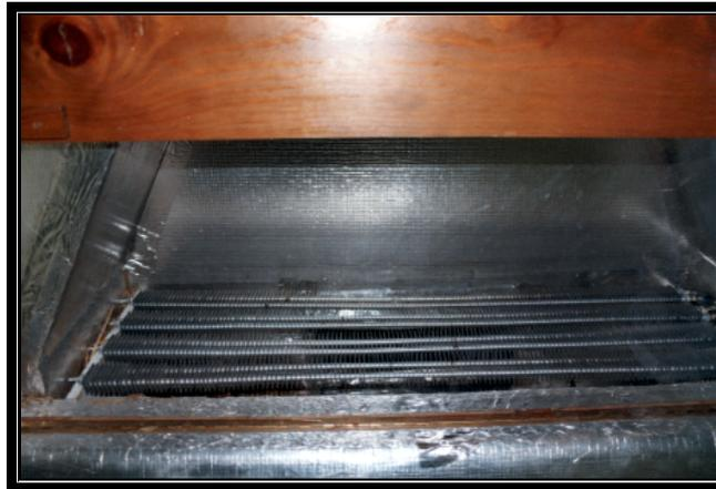
Figura 4.- Resistencias eléctricas instaladas en el secadero.
