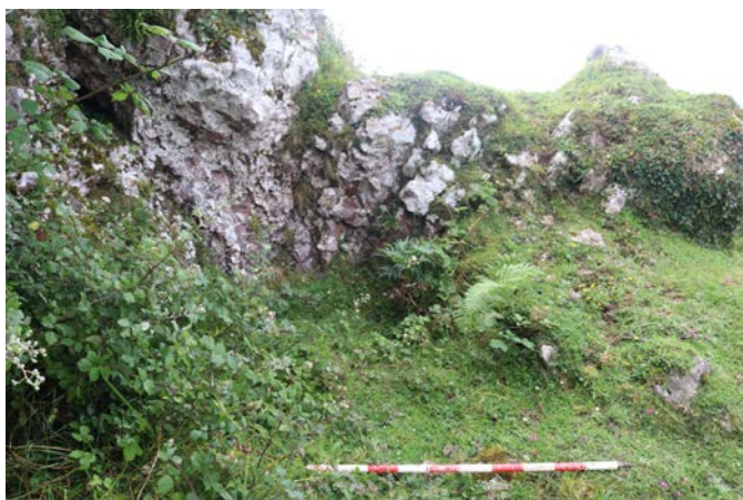
Figura 5.15_ Estructura documentadas en la zona de Buxana/Busañe sobre Entel.lago.
