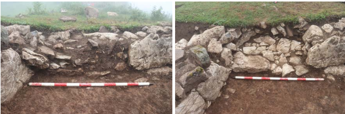
Figura 5.20_ Vano en el muro oeste de la C-2, antes y después de retirar el derrumbe que lo cegó.
