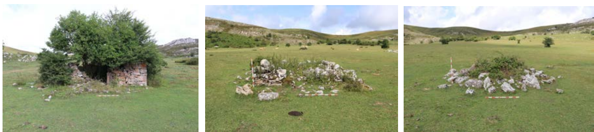
Figura 5.77_ Cabañas en distinto estado de ruina en Vega'l Práu.
