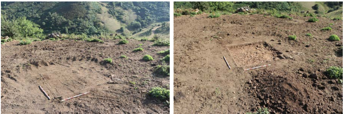
Figura 5.89_ Fotografías del S-1, inicio y final de excavación.
