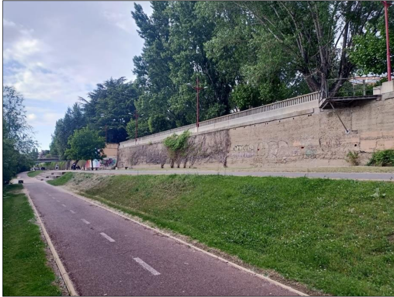
Figura A.2.3. Configuración del terraplén dispuesto en el margen derecho (orientación aguas arriba) de la parte media del tramo, en el que se distinguen dos niveles diferenciados intercalados por pendientes. El nivel inferior con un carril bici y el superior con una senda pavimentada. De fondo se dispone el muro de hormigón, perteneciente a la primera fase de canalización en este segmento; se aprecia un deterioro notable en comparación con la pasarela que sostiene encima, estando descorchado y con vegetación creciendo sobre el mismo. Este muro supone un obstáculo para el aporte de sedimentos al curso fluvial, y acentúa la desconexión entre el río y su ribera, que en este caso son inexistentes. (Fuente: Elaboración propia).
