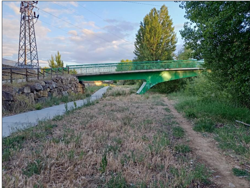
Figura A.2.13. Fotografía dentro de la zona inferior del tramo, con orientación aguas abajo. Es evidente la barrera en el desarrollo de la vegetación de ribera, en la que se pasa de una vegetación de gran porte en la orilla, a pastos bajos en la zona de paseo superior. El desaprovechamiento del espacio lateral es evidente. En la parte izquierda se puede reconocer el acceso a los usuarios en forma de rampa, que se ha dispuesto sobre una escollera de bloques descubierta, posiblemente con la intención de que también actúe como estructura de protección en caso de avenidas (Fuente: Elaboración propia).
