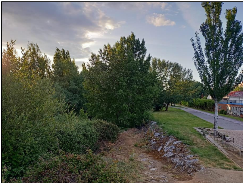
Figura A.2.6. Fotografía de un corte en la zona de paseo hasta la orilla, que permite discernir la diferencia de altura entre la orilla (En la base del árbol central) y la parte superior del talud (sobre la que se dispone la zona de paseo) (Fuente: Elaboración propia).
