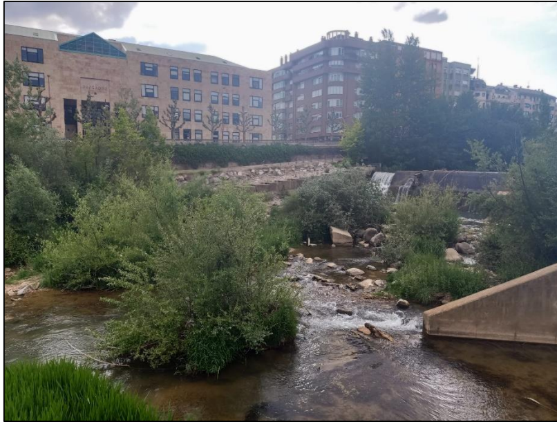
Figura A.2.6. Fotografía de la parte inferior del azud de la central hidroeléctrica con orientación aguas arriba (Fuente: Elaboración propia).
