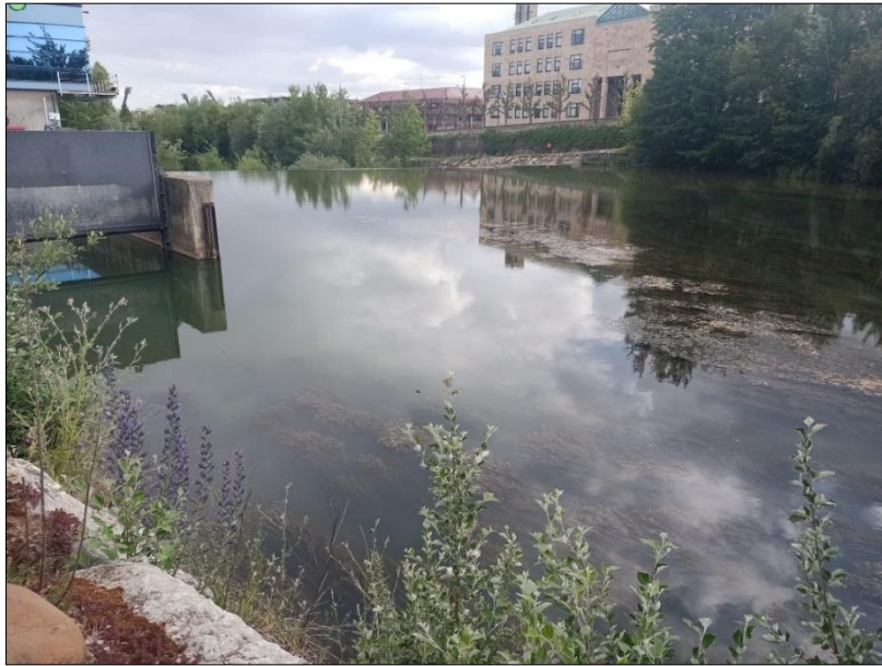
Figura A.2.1. Fotografía de la parte superior del azud de la estación de generación hidroeléctrica (a la izq.). El azud ha conllevado la aparición de una zona de remanso de mayor profundidad, en la que se puede observar una gran cantidad de plantas acuáticas ocupando gran parte del cauce. En la parte inferior izquierda y en la parte superior central en el fondo se pueden discernir escolleras dispuestas en las orillas. Estas se encuentran en ambas márgenes, siendo así tanto aguas arriba como aguas abajo para la porción del tramo (Fuente: Elaboración propia).
