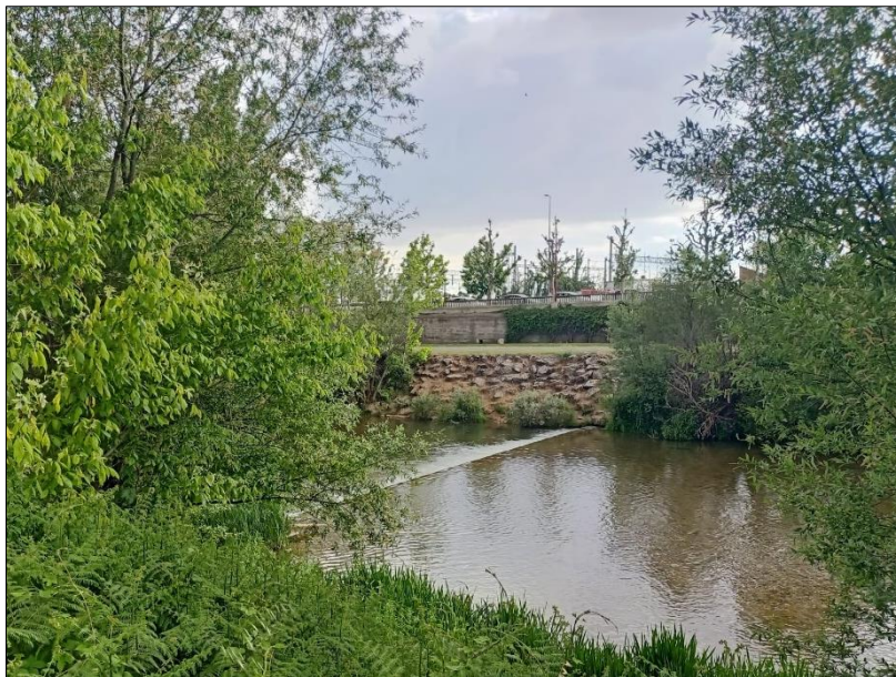
Figura A.2.2. Fotografía de la parte inferior del tramo de estudio. Se pueden observar una traviesa junto a una escollera de unos 2 metros, que une la orilla con la zona elevada de pase. Es apreciable la carencia de una estructura vegetal de ribera natural, ya que no se presenta una orilla con una configuración suave. (Fuente: Elaboración propia).
