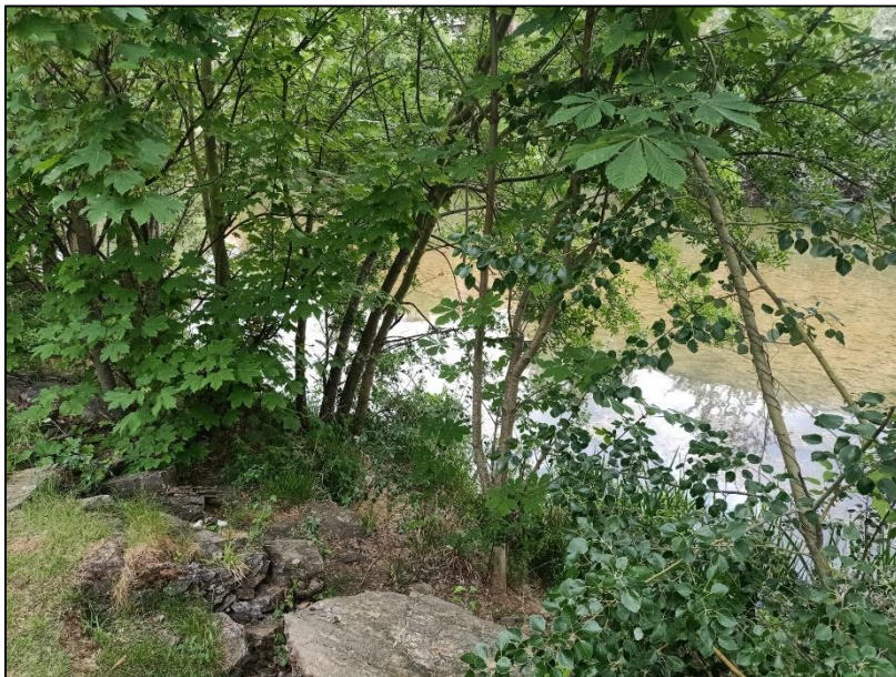
Figura A.2.4. Fotografía de la orilla izquierda en la porción media de tramo. La vegetación ha cubierto una antigua escollera, en la que los niveles de humedad y poca inclinación ha producido la formación de suelo sobre la que se ha establecido un corredor vegetal con la anchura de la propia orilla. El material de la escollera se encuentra degradado y la estabilidad se puede ver comprometida, y se aprecia en la esquina inferior izquierda el corte súbito al césped que se encuentra en la zona de paseo. (Fuente: Elaboración propia).
