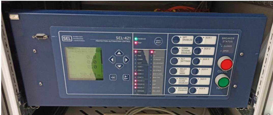
Figura 3.4: Parte anterior del relé de protección SEL-421-5 (Fuente: elaboración propia)
