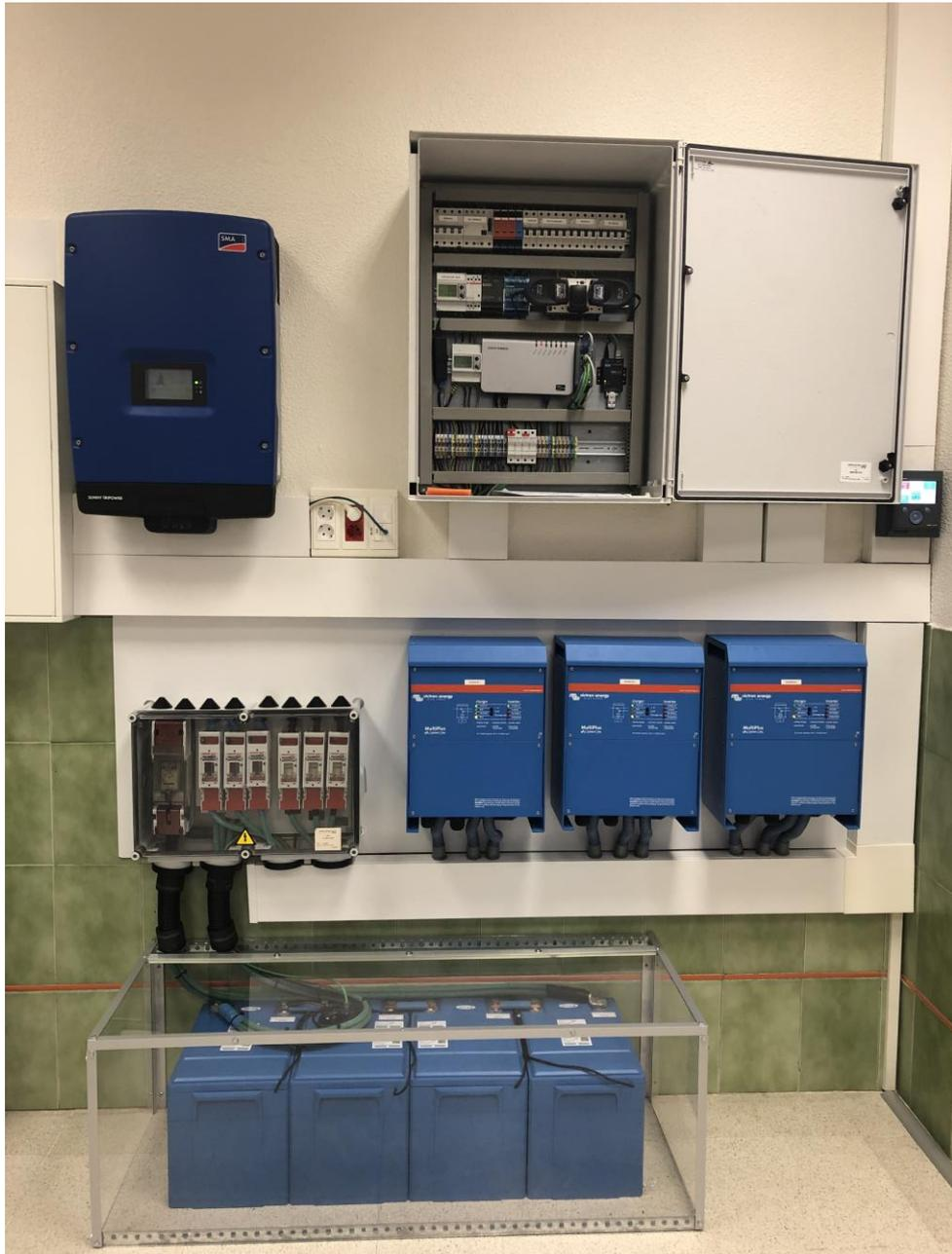
**Figura 2.8: Conjunto de inversores y cargadores de baterías junto con el cuadro de protección (Fuente: elaboración propia)**
