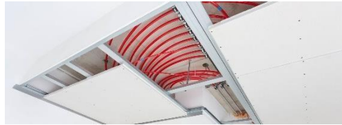
Ilustración 0.2 Techo radiante
