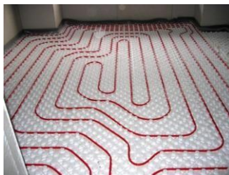
Ilustración 0.1 Suelo radiante
