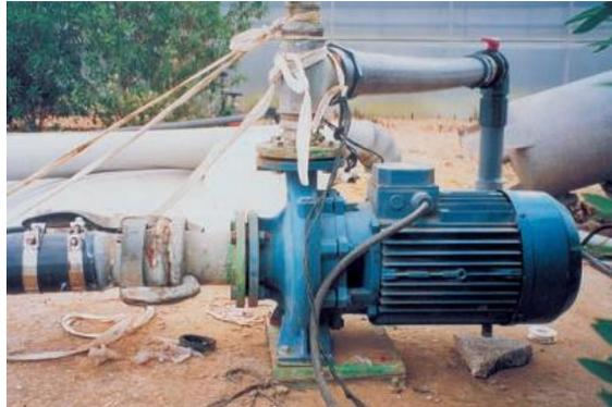
*Figura 3.1.5.2. Bomba eje horizontal (Fuente: Riego por aspersión, Junta de Andalucía)*
