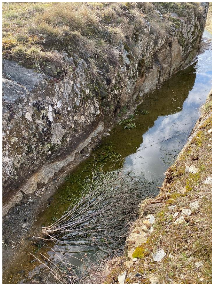
Figura 3.4 Picado en la roca para la construcción del canal de transporte de agua en Corporales.
