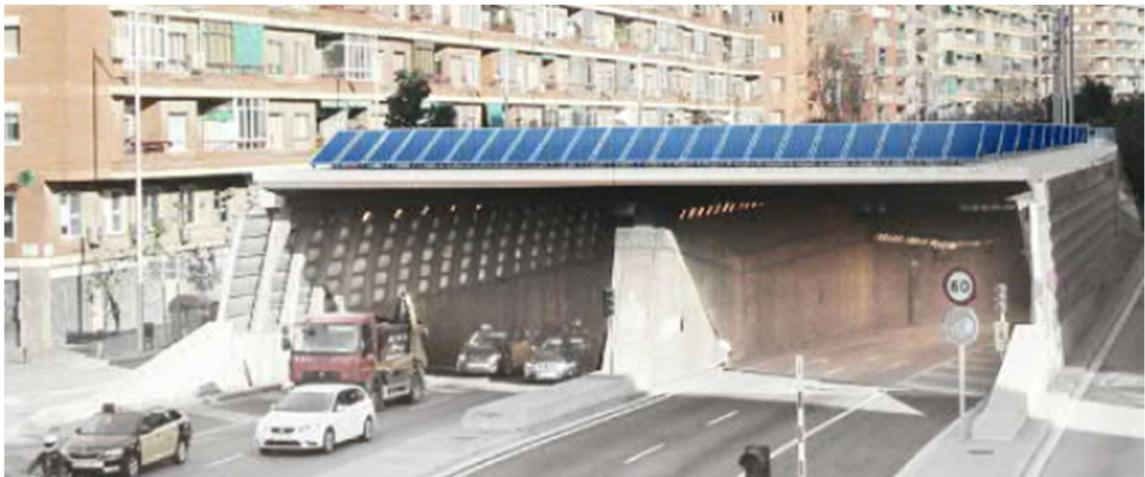
**Figura 2.17. Túnel de la Rovira. Instalación de planta FV en boca sur. Fuente: <https://ajuntament.barcelona.cat/>**
