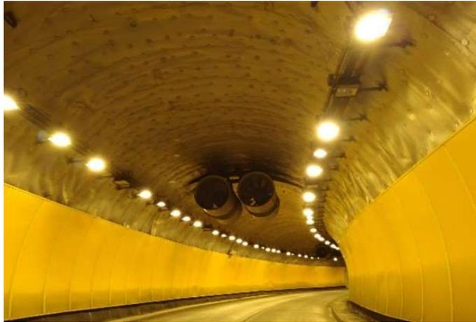
**Figura 2.7. Jet fans instalados en parejas en el túnel de Vielha (Alfons XIII). Fuente: elaboración propia.**
