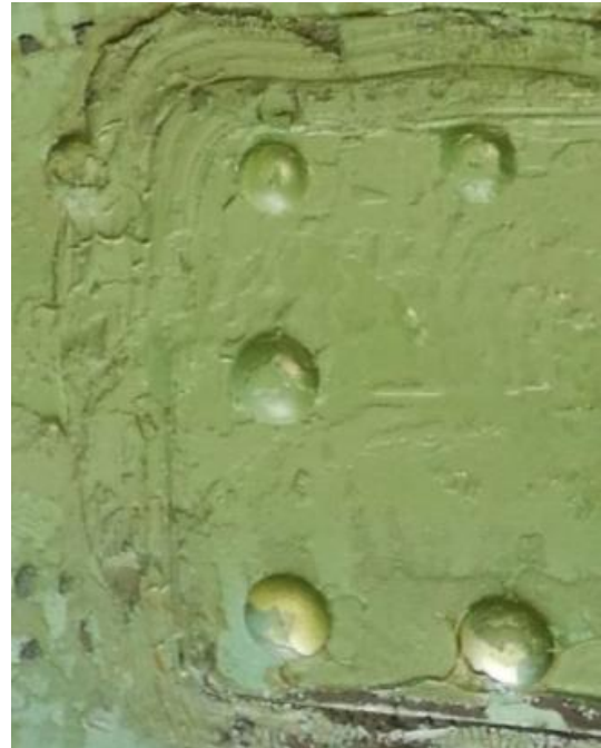
Figura 5.36: Zona 2 tras saneado y pintado. (Fuente: Elaboración propia)
