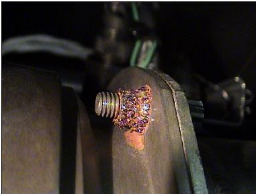
Figura 2.24: Corrosión debido a altas temperaturas. (Fuente: [1])
