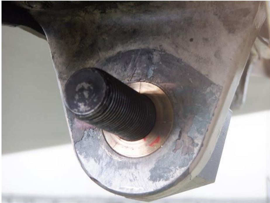
Figura 5.17: Casquillo instalado mientras recupera temperatura. (Fuente: Elaboración propia)
