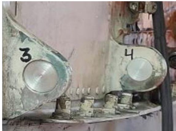
Figura 5.11: Fichas de aluminio instaladas en las orejetas. (Fuente: Elaboración propia)
