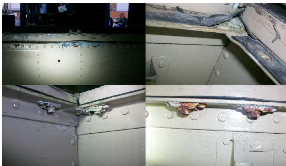
Figura 5.25: Ejemplos de corrosión bajo el suelo de la cabina. (Fuente: Elaboración propia)
