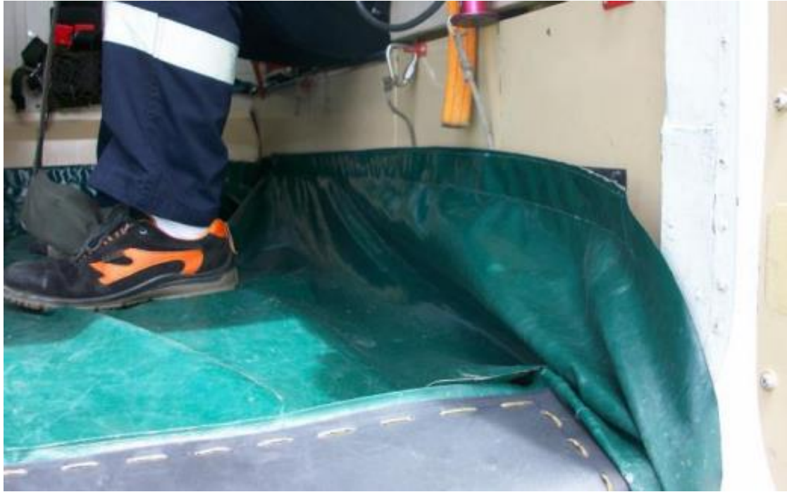
Figura D.9: Vista del anclaje de las piscinas. (Fuente: [29])
