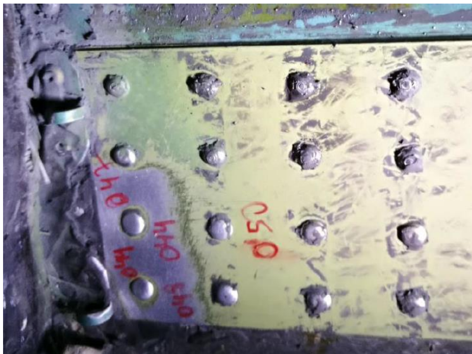
Figura 5.35: Medidas tomadas por ultrasonidos del espesor remanente en el parche volumétrico de la zona 1. (Fuente: Elaboración propia)
