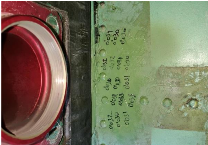
Figura 5.39: Espesores remanentes tras el saneado de la zona 3. (Fuente: Elaboración propia)
