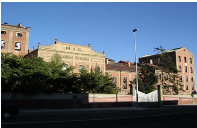
Figura 1. Azucarera “Santa Elvira” (León). Fachada principal.
