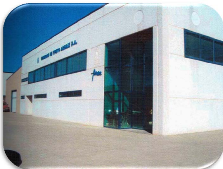
Figura 8.2. Fachada principal de las nuevas instalaciones
