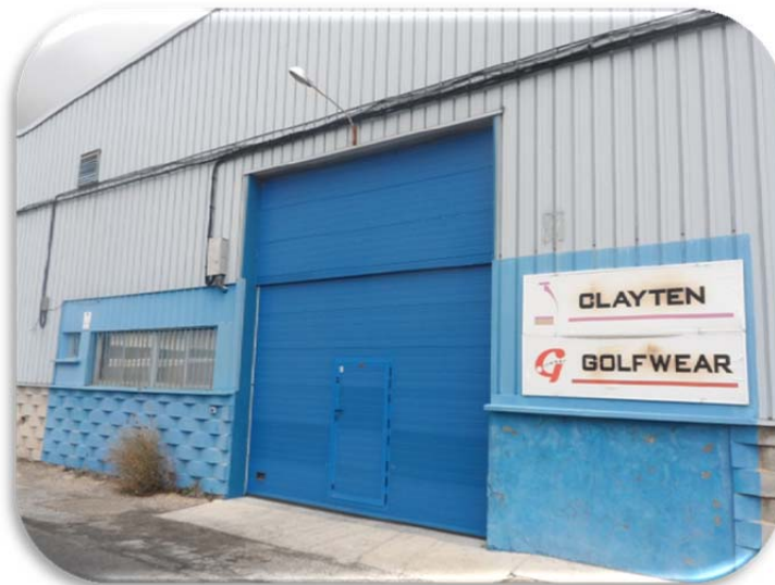
Figura 9.10. Nave industrial de comercialización de la marca Arnaiz
