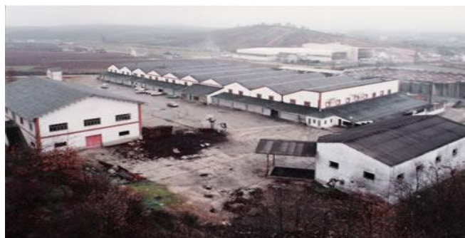
Figura 4.1. Instalaciones Bodega Cooperativa “Viñas del Bierzo”
