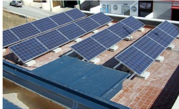
Figura 3.3. Placas integradas con distinta inclinación de la cubierta. Fuente: [10]
