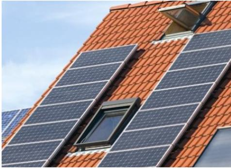
Figura 3.2. Placas integradas con inclinación de la cubierta. Fuente: [9]
