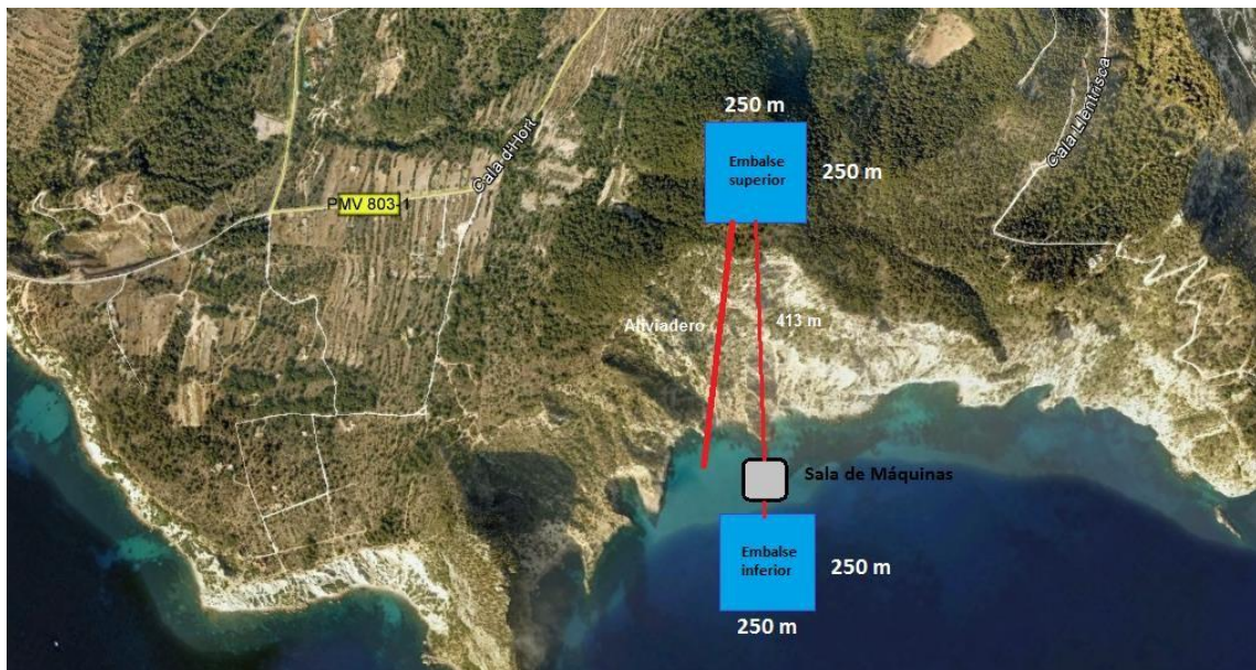
Figura 11.2. Vista aérea de la central de hidrobombeo
